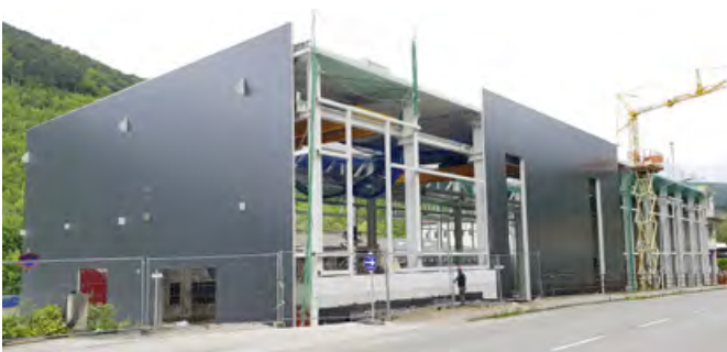
In Weissenbach entsteht derzeit ein Zubau mit 2700 m 2 Produktionsfläche, 500 m 2 Büroräumen sowie 870 m 2 überdachten Lagerflächen
