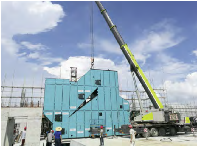
Montage einer 32,6-MW-Dampfkraftanlage in China – die Coronapandemie hat die Produktion von Polytechnik bislang nur geringfügig beeinträchtigt
