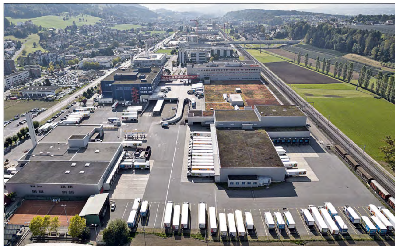
Seit Ende November versorgt eine Wärme-Kälte-Kraft-Kopplungsanlage die Betriebszentrale von Migros Luzern mit Strom, Wärme und Kälte aus Altholz. Fotos: Polytechnik, Migros
