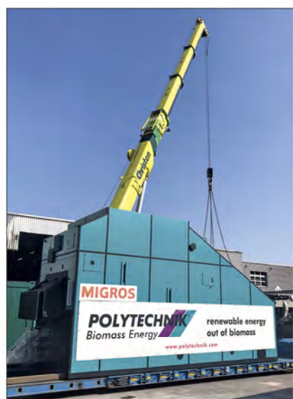
Hydraulische Vorschubrostfeuerung (Brennkammer) am Kran
