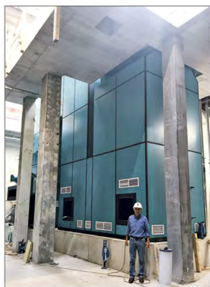
Nach kurzer Zeit war die Brennkammer montiert.
