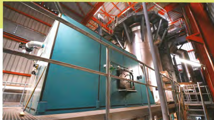
Hydraulischer Vorschubrost mit aufgesetztem Thermoölkessel
