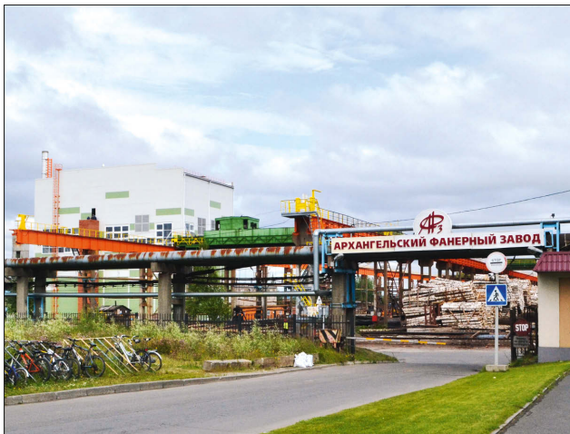
Eingang zum Werk; links ist die neue Heizzentrale zu erkennen, die seit Februar im Regelbetrieb läuft
